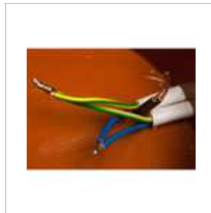
Verbinden der beiden Neutralleiter und Erden, anschließend mittels Lüsterklemme. Quelle: www.Plasma-Energie.org
