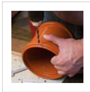
Fräsen des Langloches in der Überschiebemuffe. Quelle: www.Plasma-Energie.org
