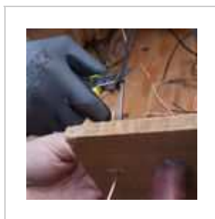
Gleichzeitiges Abisolieren mit Messer (mehrere Personen notwendig). Quelle: www.Plasma-Energie.org
